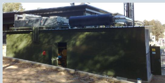
Les **panneaux acoustiques** « Zed 102 » de COMETAC sont des panneaux sandwich sur mesure. Les matériaux utilisés lui confèrent un indice d'isolement et un coefficient d'absorption élevé.
